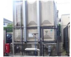
加圧ポンプ又は揚水ポンプの受水槽を撤去し増圧ポンプに変更する。
